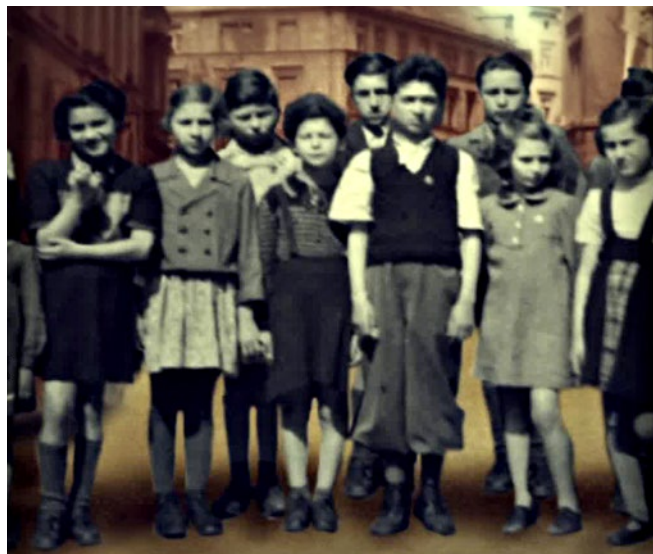
Dzieci uratowane z Zagłady w bunkrach leśnych na tle rozebranego budynku Żydowskiego Seminarium Teologicznego na ulicy Włodkowica.
